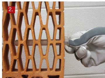
2. Установить в просверленное отверстие соответствующую сетчатую гильзу.
