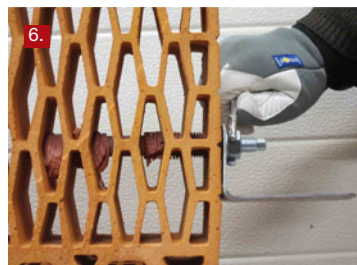
6. После полного отверждения химического состава можно прилагать нагрузку.
